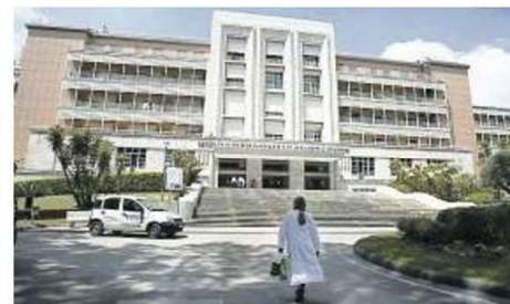
MONALDI Il presidio dell'azienda dei Colli ha il depuratore più moderno, in grado di rispettare senza problemi i limiti di legge imposti per il trattamento e la chiarificazione dei liquami
