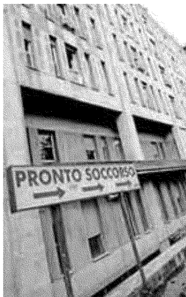
Allarme Il San Giovanni Bosco; sopra i locali invasi dalla pioggia
