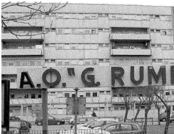
La struttura L'edificio principale del «Rummo»
