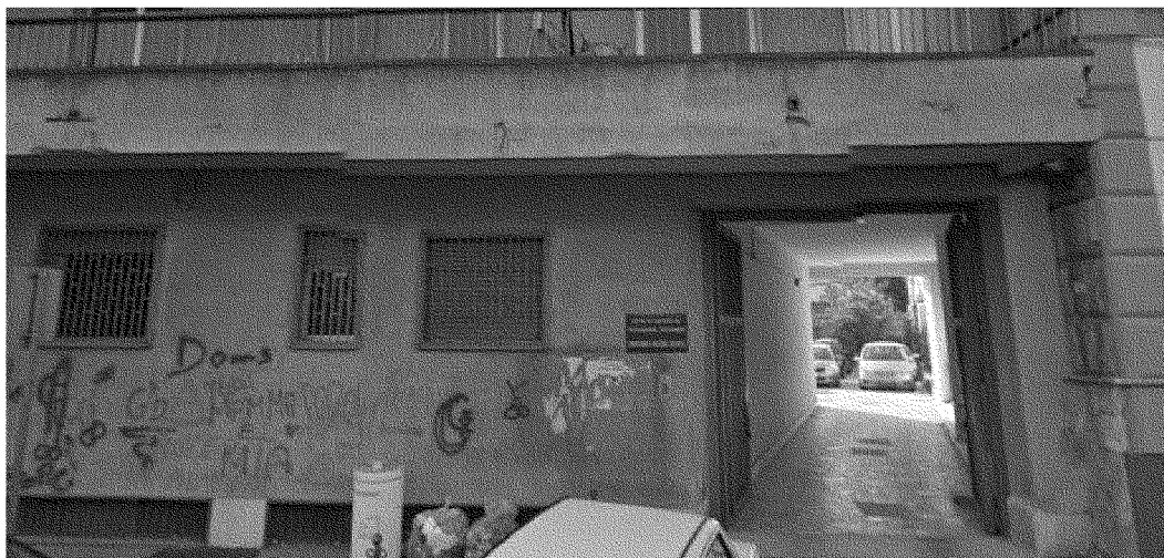
La sede del Distretto 41 dell'Asl in via Vittorio Emanuele III a Frattamaggiore
